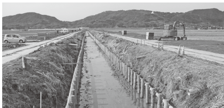
▲県営クリーク防災事業の整備状況
