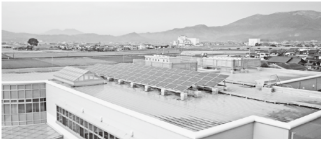
▲新庁舎屋上のソーラーパネル
