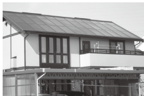
▲設置された太陽光パネル
