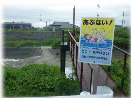
危険箇所点検 水難防止看板と浮き輪（ポリ）の保全
