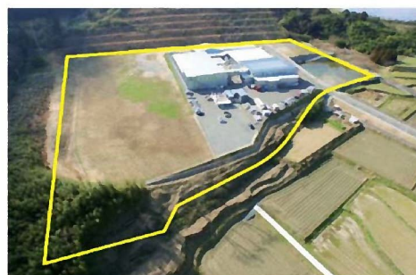
▲ 小城岩蔵工業団地 (区画面積：約25,000m 2 )
