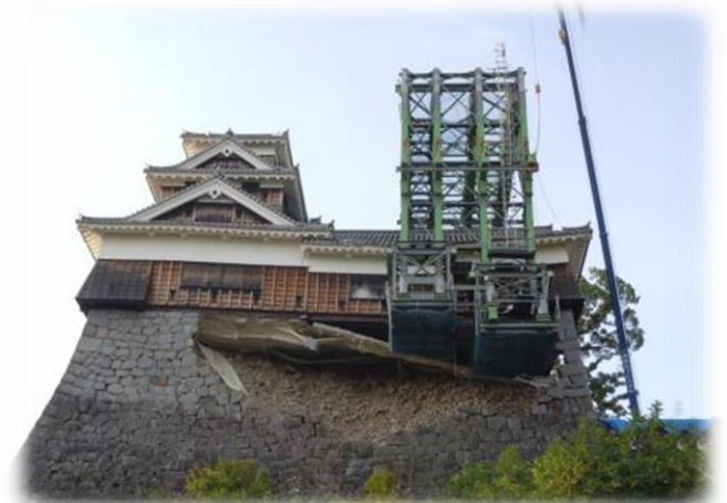
熊本城 応急工事
