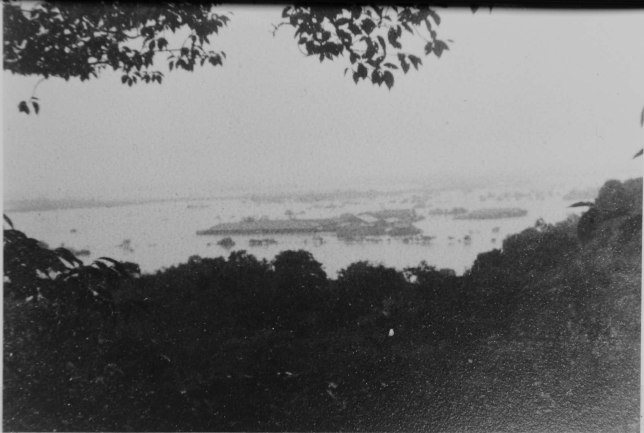
山腹から写した今にも水没しそうに見える岩松小の校舎屋根！
