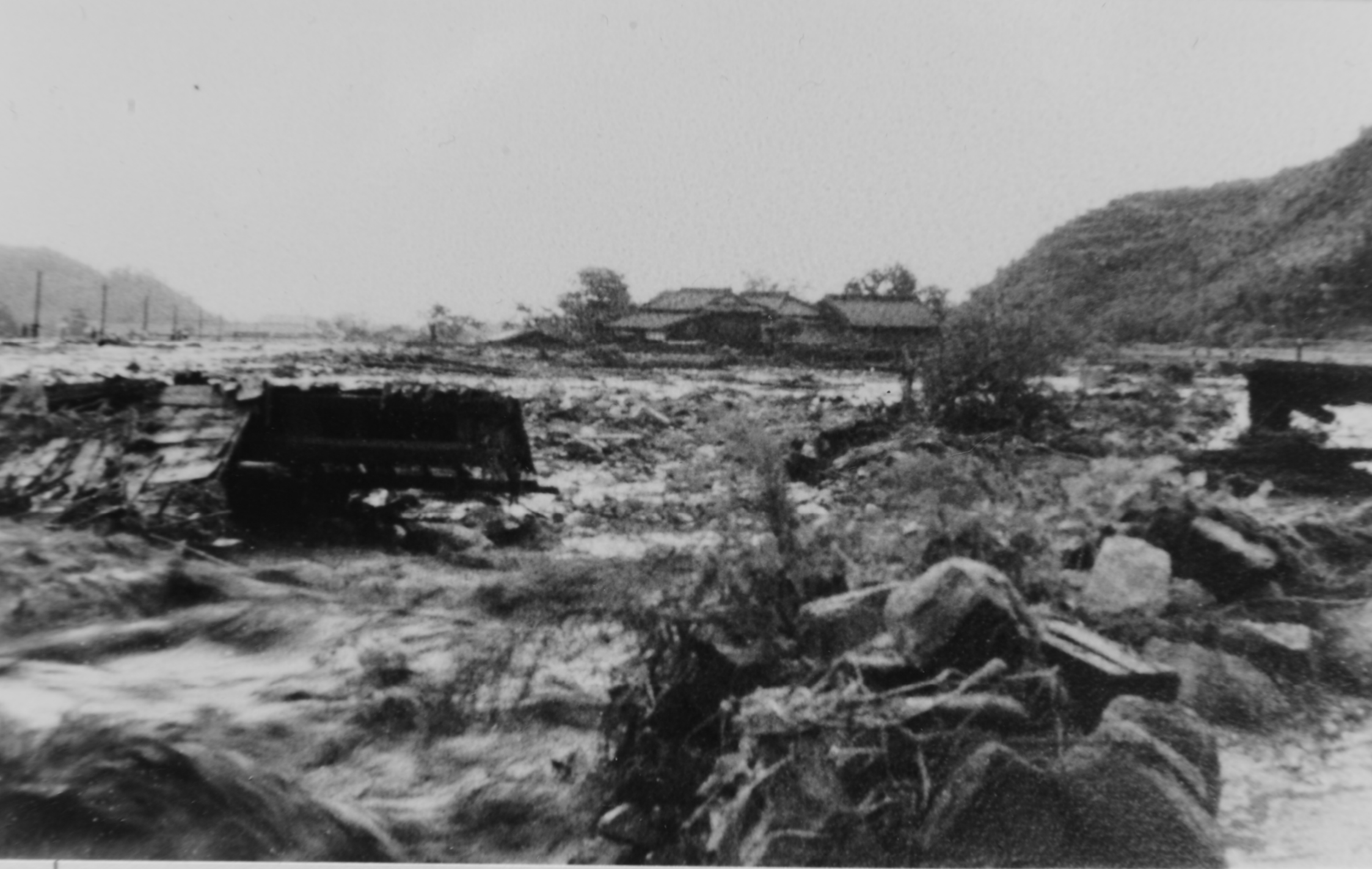
跡形なく流失した天山酒造の母屋と半分残った天山橋
