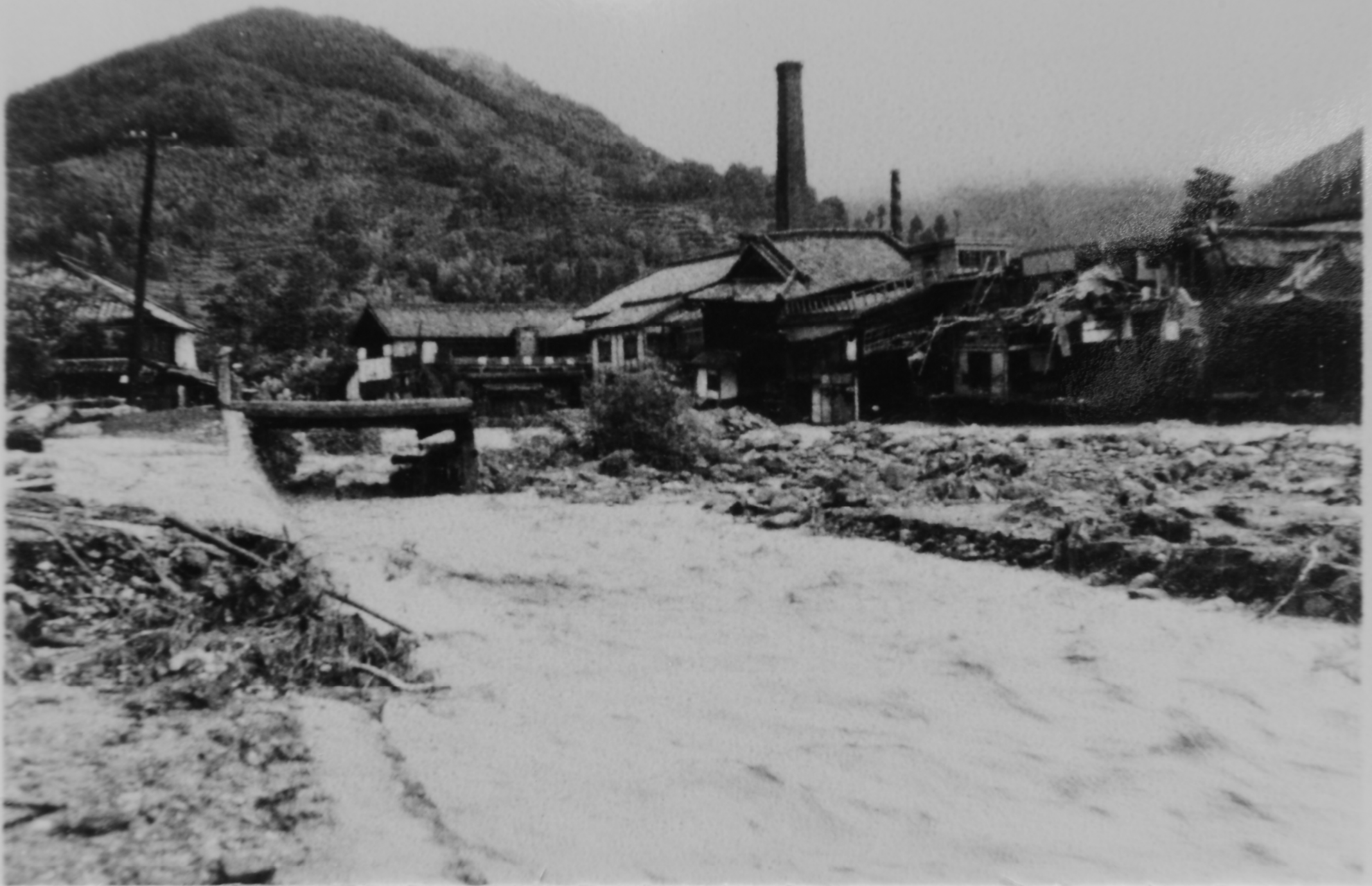
天山酒造の母屋社屋が完全に流出しその後の建物は川へ傾く
