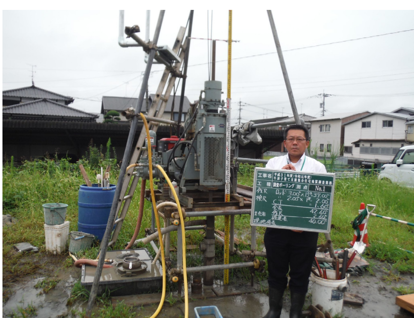
ロッド残尺(遠景)
