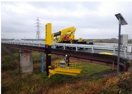
橋梁点検車による定期点検
