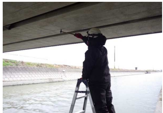
定期点検(打音検査)状況
