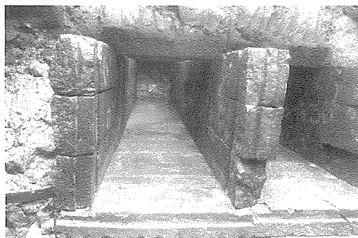
イッスイ井樋の石組み
