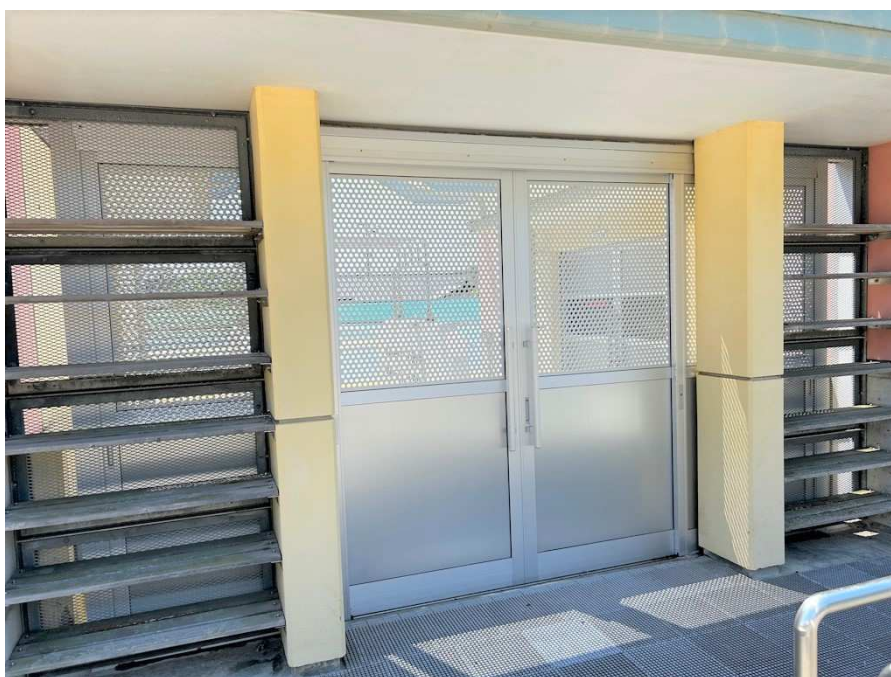
【令和6年度】小中学校施設改善事業 (晴田小学校 プール出入口建具取替工事)
