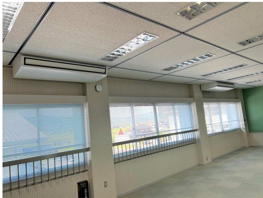
【令和6年度】小中学校施設改善事業 (三日月中学校 パソコン室空調機整備工事)
