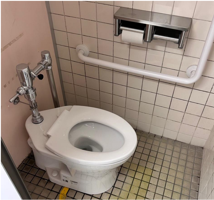
【令和7年度】小学校施設改善事業 (三日月小学校 1・2階女子トイレ洋式化工事)
