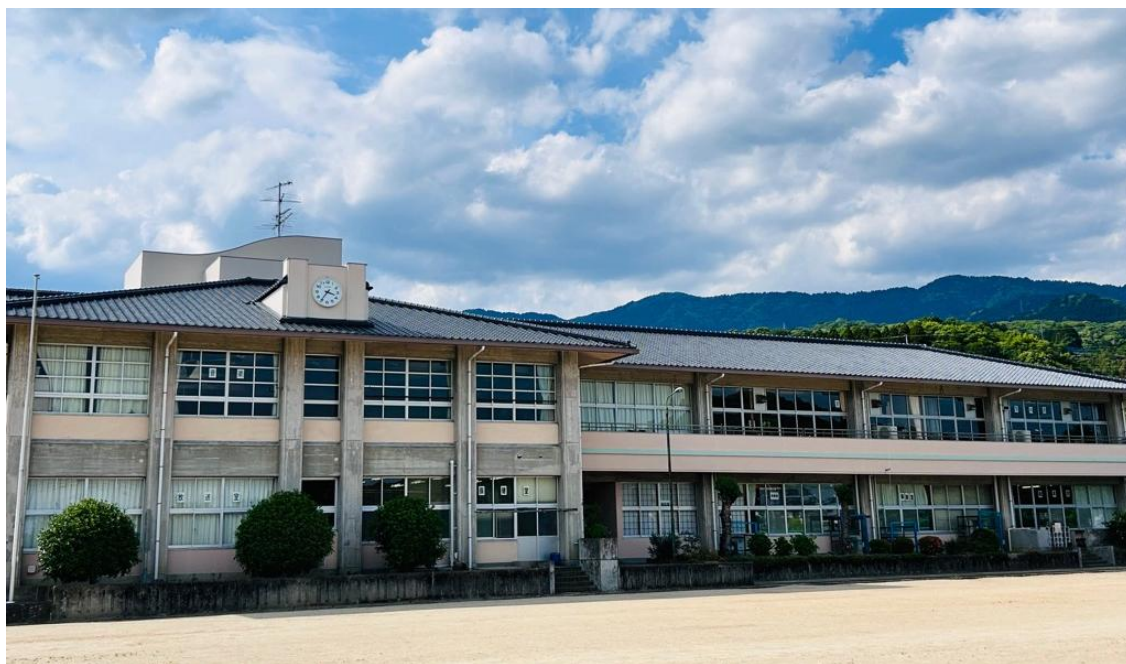
【令和7年度】小学校施設改善事業 (岩松小学校 屋根及び外壁改修工事)
