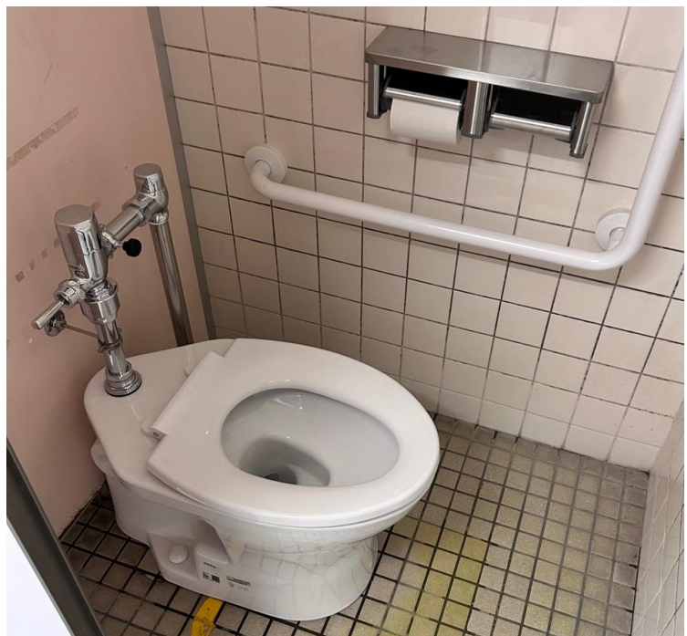
【令和7年度】小学校施設改善事業 (三日月小学校 1・2階女子トイレ洋式化工事)
