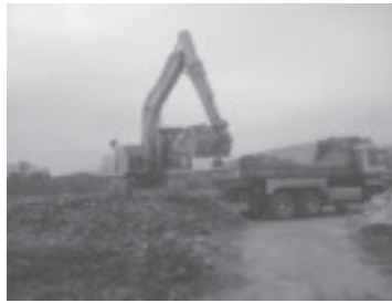
▲台風13号で出たガレキの処理作業
