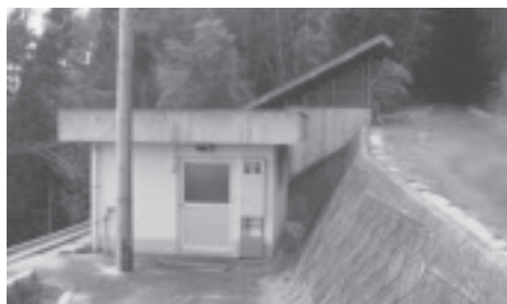
▲源五郎第一加圧機場の改修にもあてられる
