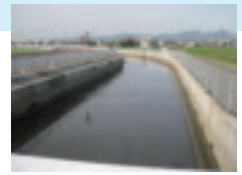
改修後の幹線水路
